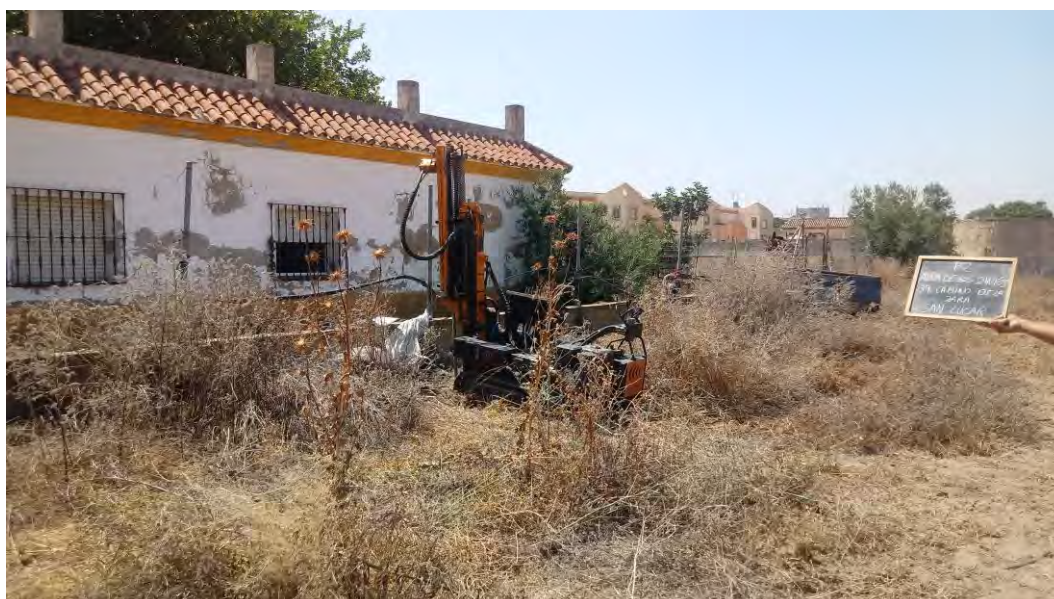
ENSAYO DE PENETRACIÓN DINÁMICA CONTINUA Nº 2
