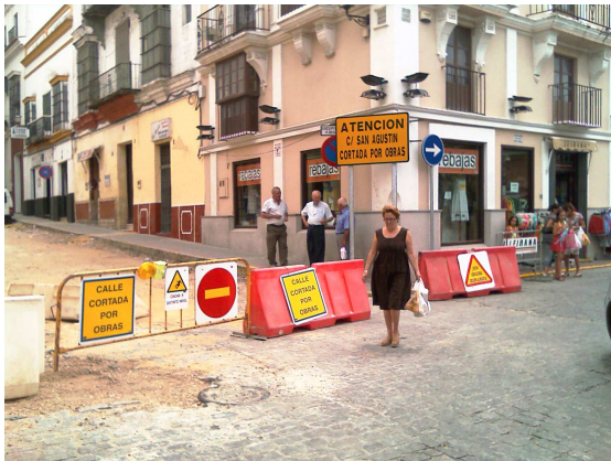
SEÑALIZACION Y VALLADO DE CABECERA DE OBRA
