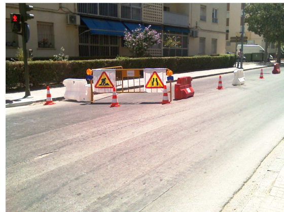
CARRIL OBRA SEÑALIZADO
