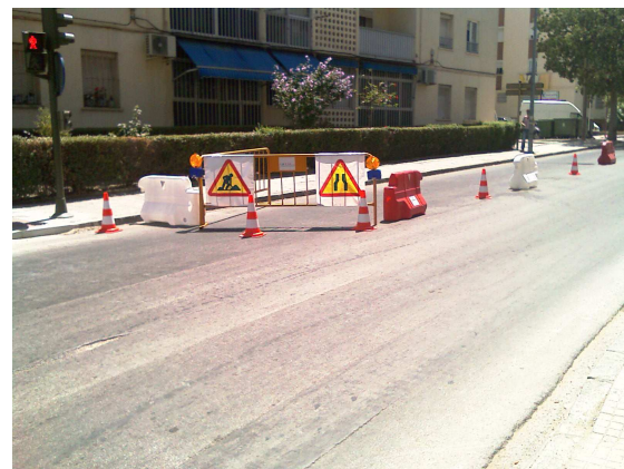
CARRIL OBRA SEÑALIZADO
