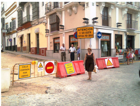
SEÑALIZACION Y VALLADO DE CABECERA DE OBRA
