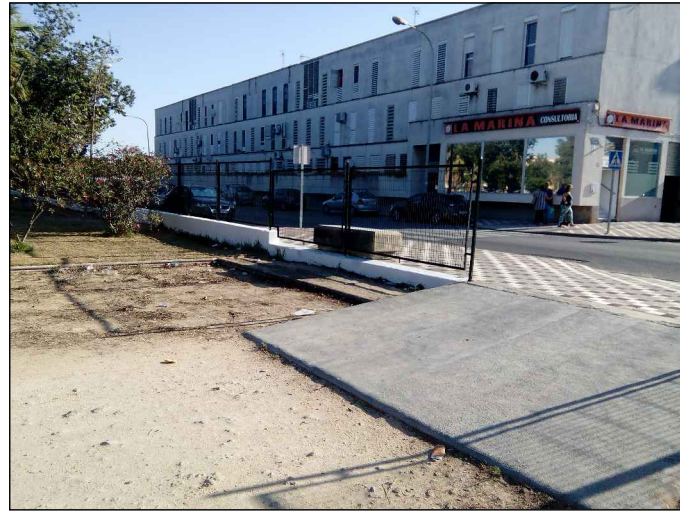
FOTOGRAFÍA nº 13 (Acceso por Avenida de la Marina, detalle)
