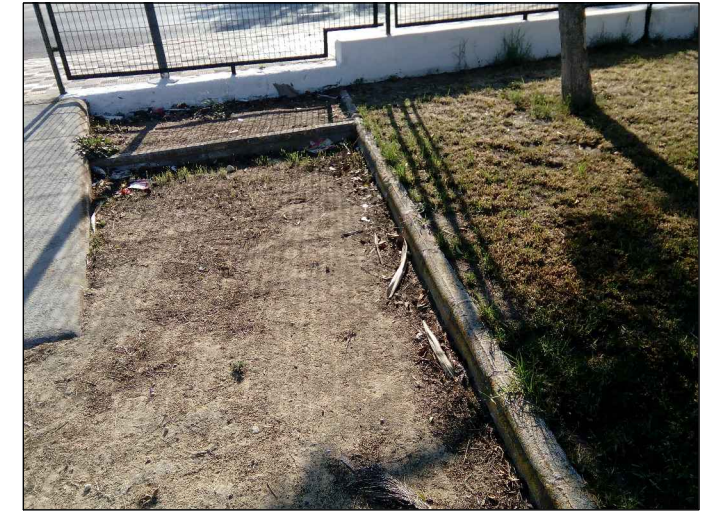
FOTOGRAFÍA nº 16 (Acceso por Avenida de la Marina, detalle)
