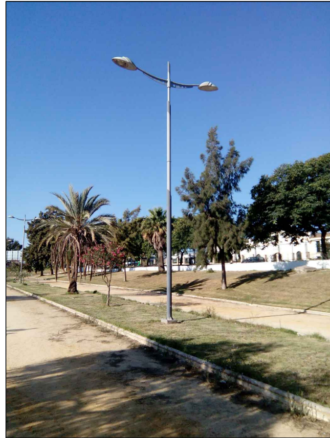
FOTOGRAFÍA nº 36 (Detalle de punto de luz, dos brazos)
