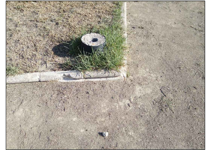
FOTOGRAFÍA nº 36 (Detalle de boca de riego)
