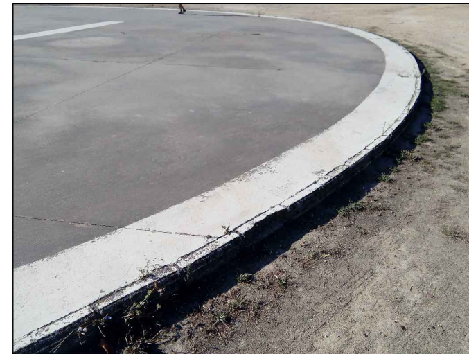
FOTOGRAFÍA nº 23 (Helipuerto, detalle de pavimento y encintado)
