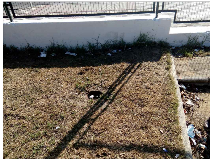
FOTOGRAFÍA nº 17 (Acceso por Avenida de la Marina, detalle)
