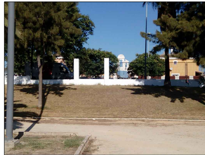
FOTOGRAFÍA nº 18 (Cerramiento Avenida Rocío Jurado)
