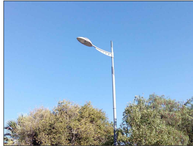
FOTOGRAFÍA nº 35 (Detalle de luminaria)
