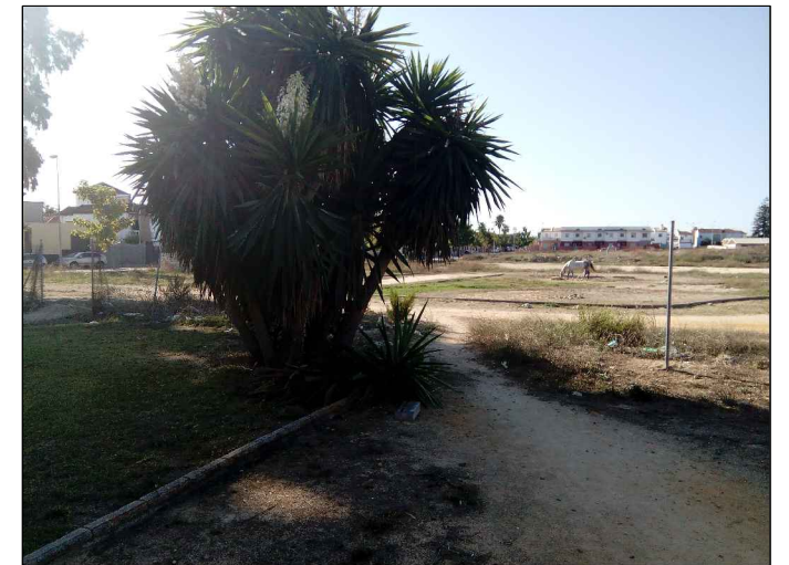
FOTOGRAFÍA nº 12 (Estado de cerramiento)
