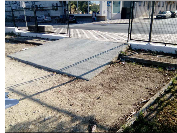
FOTOGRAFÍA nº 15 (Acceso por Avenida de la Marina, detalle)
