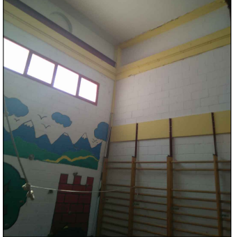
Interior del pabellón 1
