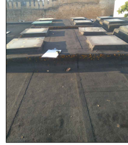
Zona de cubierta 1
