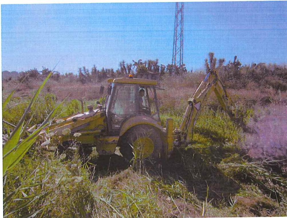
Posicionamiento del equipo retro-excavadora durante la ejecución de la calicata C-1. Zona de navazo.
