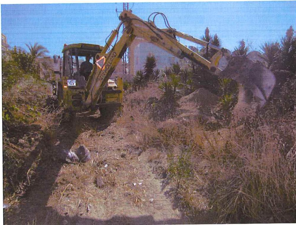
Posicionamiento del equipo retro-excavadora durante la ejecución de la calicata C-2. Zona de bardo.
